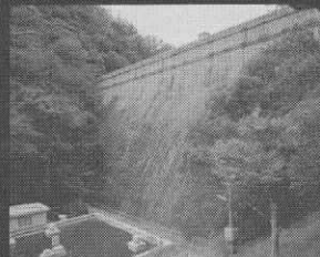
◎五本松堰堤 (布引水源地水道施設のうち) 神戸市
